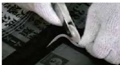
コーナー部分はゴムを少したるませ、少しずつ押し込んでいきます。一気に押し込むと、網を傷つけてしまったり、網目が変形してしまいます。
