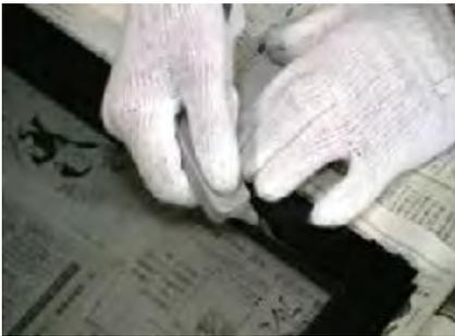
網押さえゴム（ゴムビート）のつなぎ目を探してローラーのヘラ部分で端部分を引き出します。
